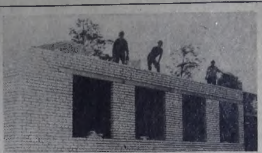
Много новых объектов строится в городе для улучшения обслуживания населения. На этом снимке В. Небогина — начало строительства санатория «Бодрость», в котором будут находиться дети тех, кто проживает в микрорайоне 15. Строительством ведет бригада В. Н. Климова из СМУ-1.
