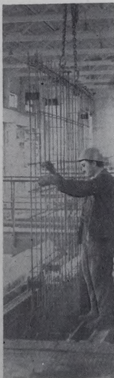
На заводе ЖБИ-2 освоено касетное производство изделий. На этом снимке — установка арматуры в касетку.
