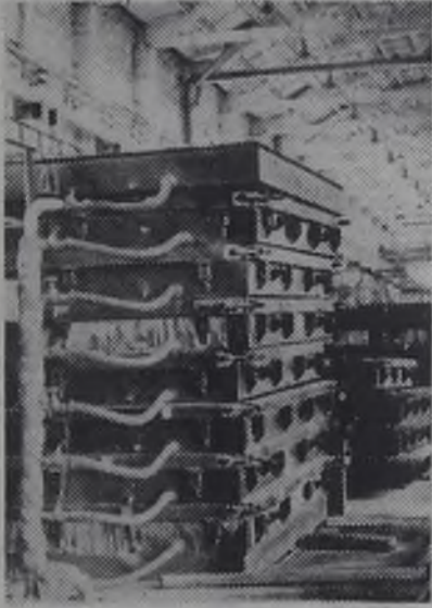
На снимках: сверху — у макета комплекса полиэтилена. Строительство по макету — прогрессивный метод. Внизу — пакеты термоформ на заводе ЖБИ-2, где изготавливаются изделия домов новой серии.
