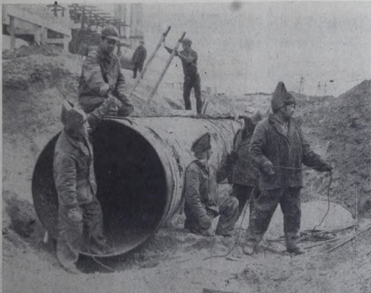
Бригада А. В. Гриценко из СМУ-4 много сделала, чтобы инженерные сети на комплексе этилена-пропилена были завершены в срок. В настоящее время этот передовой коллектив трудится на более мощном комплексе — второй очереди этилена-пропилена. Здесь трубоукладчики регулярно перевыполняют задания. На снимке: укладка труб большого диаметра. Фото В. НЕБОГИНА.
