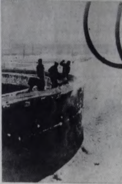
В Ангарске продолжается строительство новой очереди биологических очистных сооружений. Работы на смете ведет бригада И. А. Медешкина.
