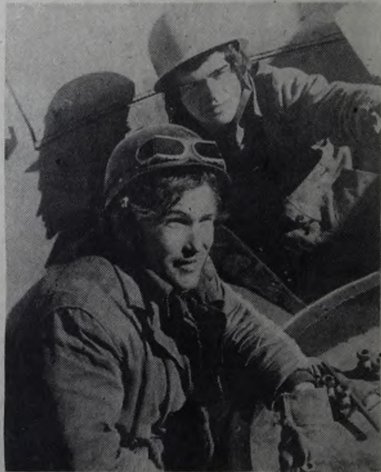
Валерий Фурсов и Валерий Гребень еще не так давно были учениками ГПТУ, а сегодня уже выполняют самостоятельно монтаж в бригаде А. Горбачева из МСУ-42 на комплексе этилбензола.
