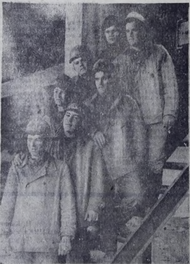
Молодежная бригада монтажников Ивана Аксютин ударно трудится на строительстве объектов АНХК. Свои задания молодые ребята регулярно перебивают.
