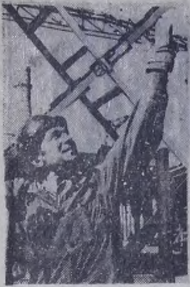
На снимке: один из лучших и опытных строителей бригады В. Ф. Олейника из СМУ-3, ударник коммунистического труда В. Ф. Болишук. Он трудится на сооружении фундаментов под компрессоры объекта второй очереди этилена-пропилена. Фото В. НЕБОГИНА.
