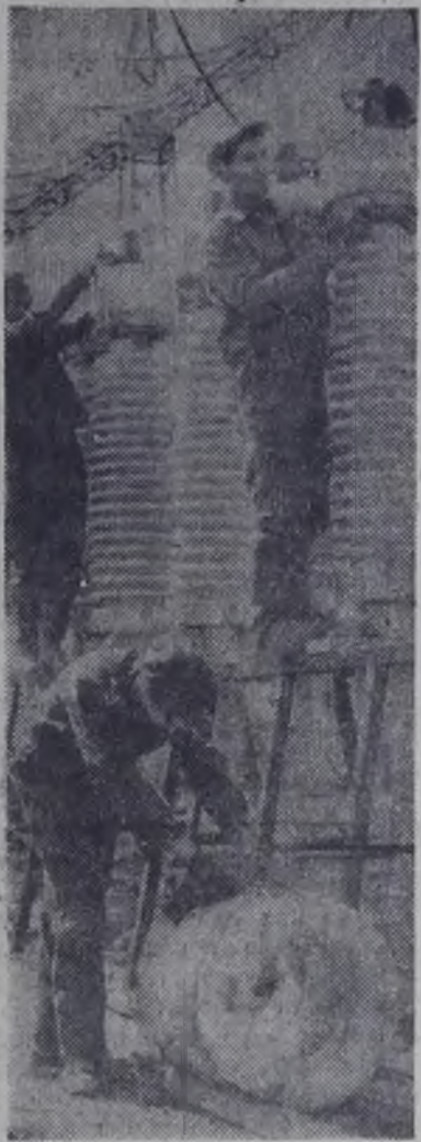
На монтаже наружной установки подстанции комплекса этилена работает бригада В. Ф. Дрипана из МСУ-76. Она успешно справляется с тематическими заданиями.
