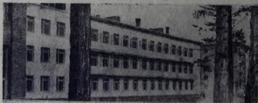
Профилакторий 208 квартала. Здесь строители заканчивают работы.
