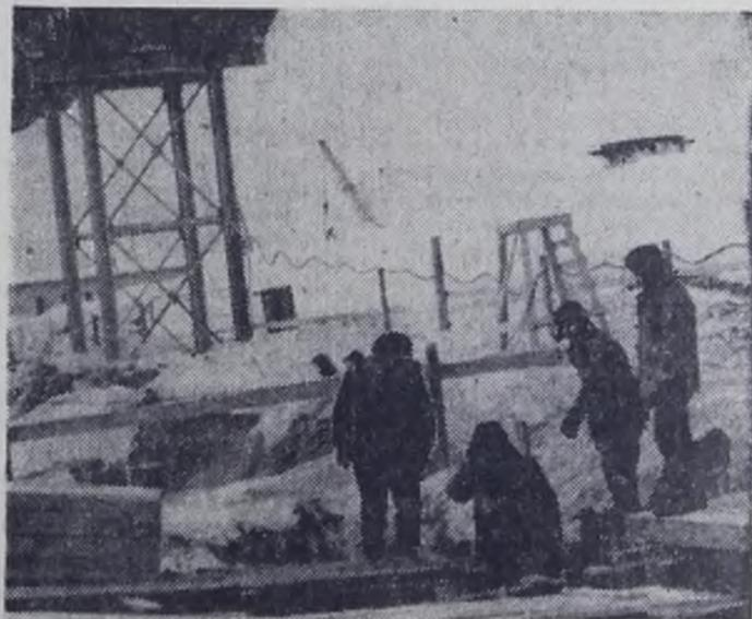
На этом снимке — работа строителей СМУ-3 на устройстве фундаментов эстакады 15а, которая на сегодня является одним из важнейших объектов для строителей и монтажников, чтобы своевременно сдать под пуско-наладку пусковые комплексы нефтехимии.
