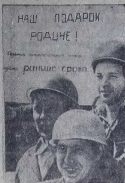
ЛИТОВСКАЯ ССР. Завершен монтаж новой технологической линии Акмянского цементного завода производительностью 600 тысяч тонн в год. Строители и монтажники всдут работы с большим опережением графика. С вводом очередной линии в действие завод ежегодно будет давать 3,5 миллиона тонн цемента.
