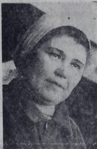
Эти снимки наш внештатный фотокорреспондент В. Небогин сделал в момент завершения работ на сдаточном цехе хлорпроизводных, где работы вело СМУ-3.
