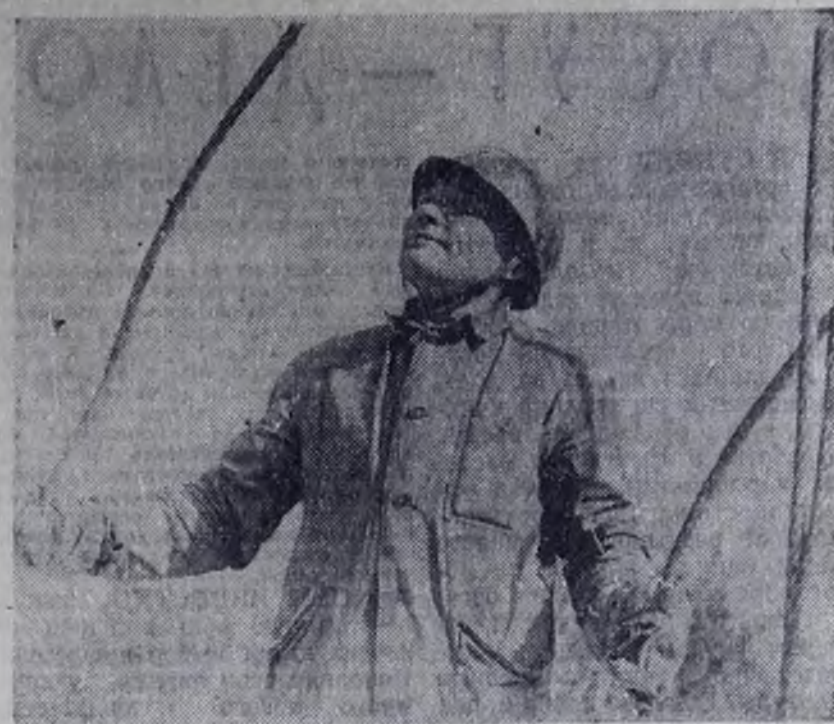
Петр Федорович Кошелев в СМУ-1 работает давно. Монтировал жилые дома, был каменщиком, а последние несколько лет работает стропальщиком в бригаде А. Сафонова. Передовой рабочий, вместе с товарищами по бригаде он сейчас строит общественно-бытовой блок ГПТУ в 6-м микрорайоне.
