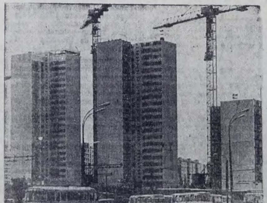
МОСКВА. Строительно-монтажное управление СКБ «Прокатдеталь» возводит в Тропареве три экспериментальных двадцатидвухэтажных жилых дома. Новые здания крестообразные в плане. В каждом из них по 147 двух-, трех- и четырехкомнатных квартир улучшенной планировки. Монтаж жилых домов ведется из унифицированных деталей по единому каталогу.
