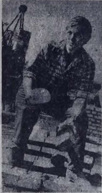
Владимир Бочкарев выбрал профессию строителя. Окончил ГПТУ, работал в СМУ-1. После службы в армии снова вернулся в коллектив демонстраторов, сейчас строит училище для треста «Востокхиммонтаж». Ударник коммунистического труда, Владимир освоил профессии монтажника и каменщика.
