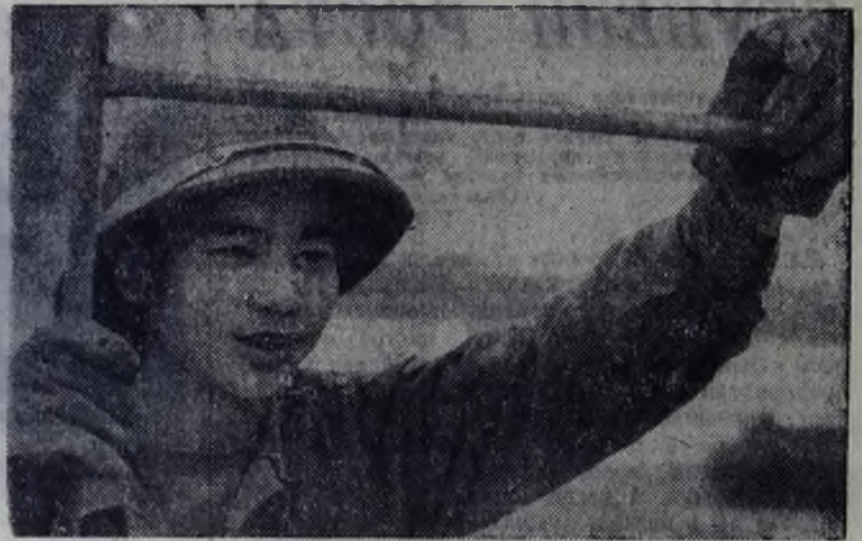
Ханой. В северо-западной части вьетнамской столицы идет сооружение нового жилого массива Зангво. Проект застройки этого микрорайона разработан сотрудниками Ханойского архитектурного института. Дома сооружаются из укрупненных блоков. К концу 1975 года здесь будет построено 55 тысяч квадратных метров жилой площади, 4 детских сада, школа, универмаг.
