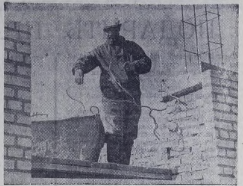
На сооружении школы в 10 микрорайоне вместе с «нулевиками» полными хозяевами стали каменщики бригады А. Сафонова из СМУ-1.
