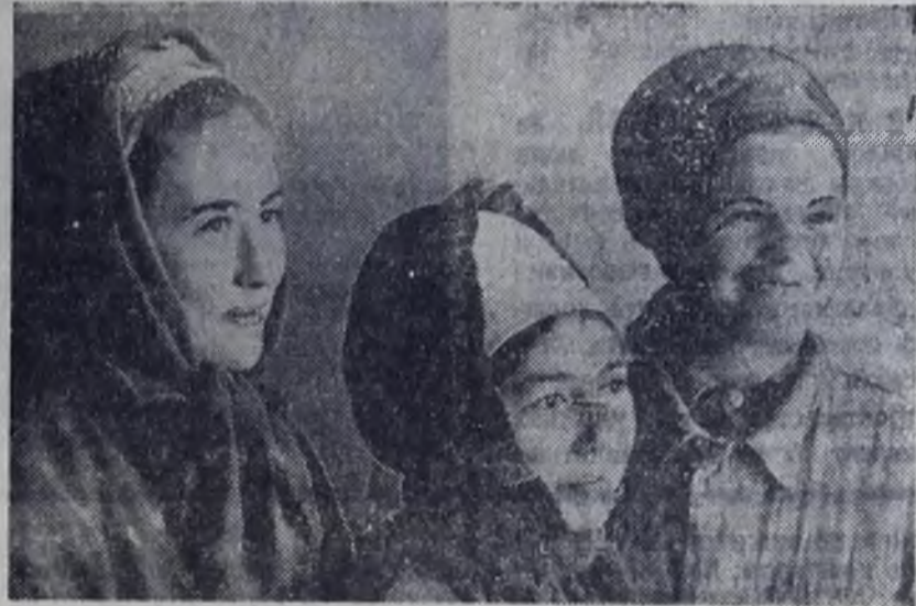
Бригада Надежды Тимофеевны Резчик из СМУ-5 работает на отделе домов пятого микрорайона в Ново-Ленино. Уже сегодня этот дружный коллектив намного обогнал время, выполняя нормы выработки на 130—140 процентов.
