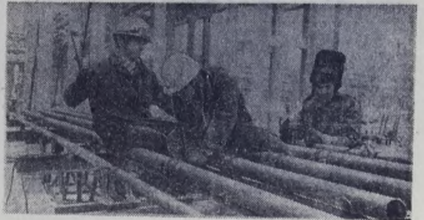
Один из методов ускорения строительства — предварительный монтаж. Его охотно используют в своей работе монтажники МСУ-42. На снимке В. Небогина — бригада В. Л. Лещенко занята предварительным монтажом конструкций на земле (комплекс по производству стирола).
