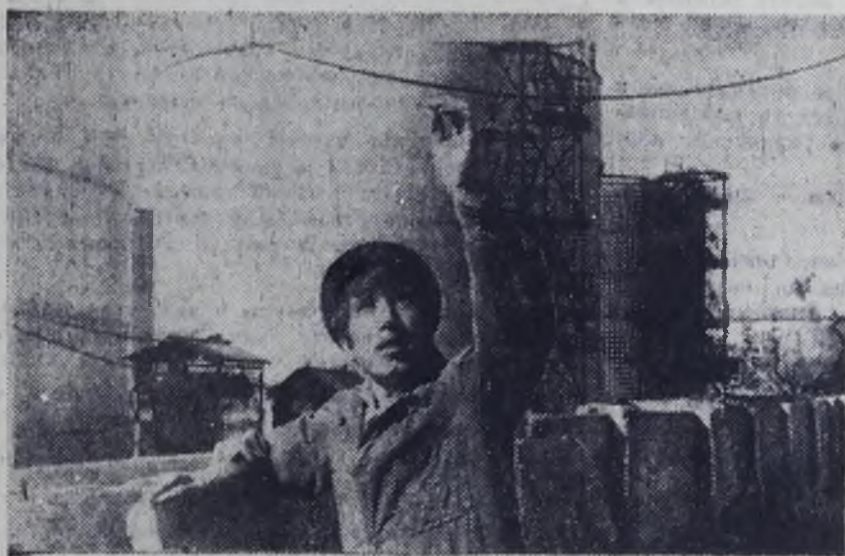
Звеньевой Анатолий Георгиевич Сухих из бригады Ф. С. Жадаева (СМУ-6), работающий на сооружении установки А-37/3.
