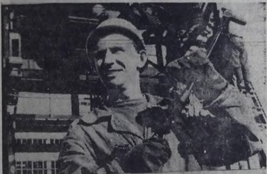
Петр Александрович Кузиков — бригадир монтажников из МСУ-42. На комплексе этилена-пропилена его бригада ведет монтаж колонн.
