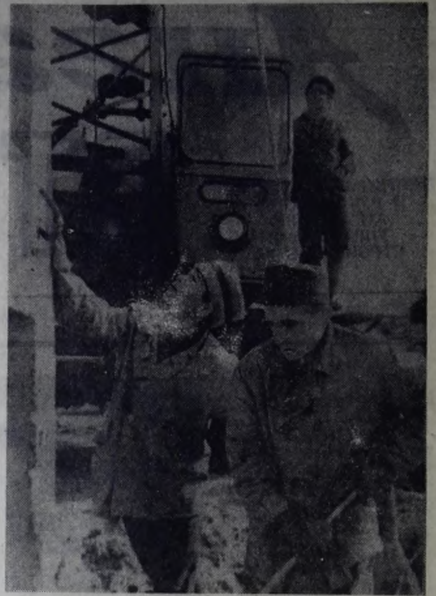
Высоких производственных показателей добилась на строительстве пускового комплекса — завода товаров народного потребления — бригада А. Л. Барабашова (1-й участок СМУ-2). До 140 процентов довел этот коллектив выполнение сменных норм выработки.
