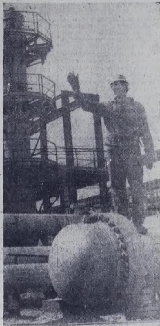
Бригада И. А. Целищева из МСУ-42 выполняет монтаж оборудования, металлоконструкций и технологических трубопроводов на объекте 18-42 комплекса этилена-пропилена.
