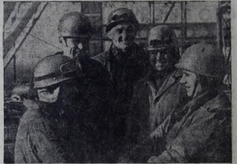
В СТОЛИЦЕ УКРАИНЫ сооружается крупнейший в стране комплекс передающей телевизионной станции. Разработку проекта телебашни и способов ее возведения осуществляли коллективы государственного проектного института «Укрпроектстальконструкция» и института электросварки имени Е. О. Патона АН УССР.
