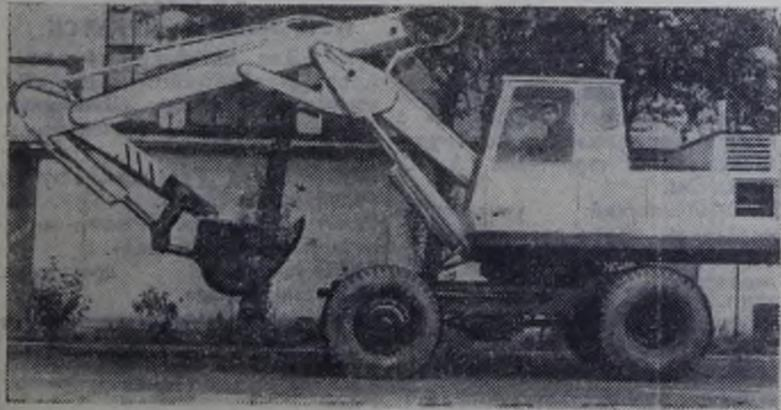
Универсальный одноковшовый экскаватор новой модели — «ЭО-3322», предназначенный для земляных работ в промышленном и гражданском строительстве, на сооружении оросительных систем и прокладке дорог, начал выпускать серийно Ленинградский экскаваторный завод. Он приводится в действие гидравликой и превосходит выпускавшийся до этого экскаватор с механическим приводом.
