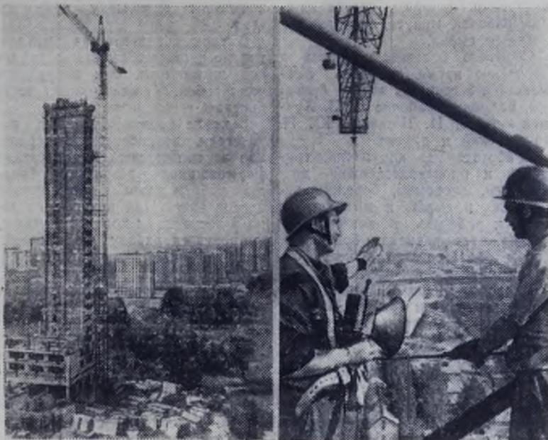
Московские строители возводят на Потылихе экспериментальный 25-этажный жилой дом с монолитным ядром жесткости — основной конструкции здания. Работы ведет специализированное строительно-монтажное управление «Энерговысотспецстрой» треста «Гидроспецстрой». Недавно строители одержали большую трудовую победу — заведет специализированное строительно-монтажное управление «Энерговысотспецстрой» треста «Гидроспецстрой».
