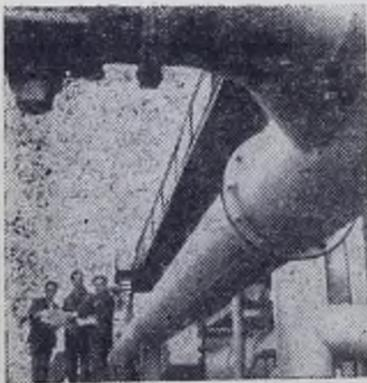
ГРУЗИНСКАЯ ССР. Недалеко от местечка Шулавери в Марнеульском районе расположены карьеры по добыче инертных материалов. Для быстрой доставки их на стройки сооружена пневмотрасса. Немногим более года работала над ее строительством коллектив Лилойского завода железобетонных изделий.
