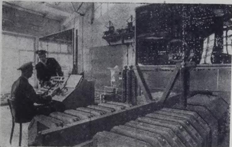
На снимке: тренажер действующей электросхемы локомотива ЧС-2, созданный изобретателями депо Ленинград-пассажирский-Московский. Он предназначен для обучения машинистов электропоездов и проверки их знаний по устранению неисправностей электрической схемы локомотива, которые могут возникнуть в пути и создать аварийную ситуацию.
