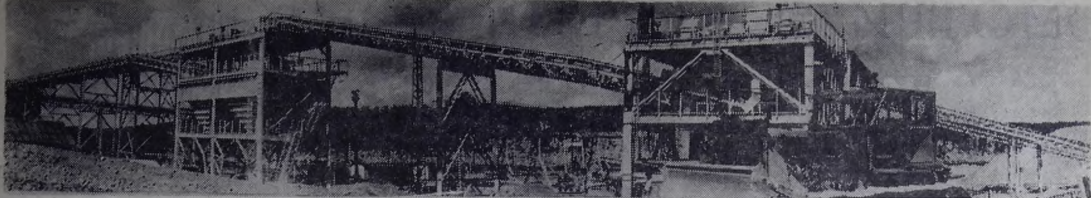
На снимке: панорама строительства гидромеханизированного завода УПП. Здесь полным ходом идут пуско-наладочные работы.
