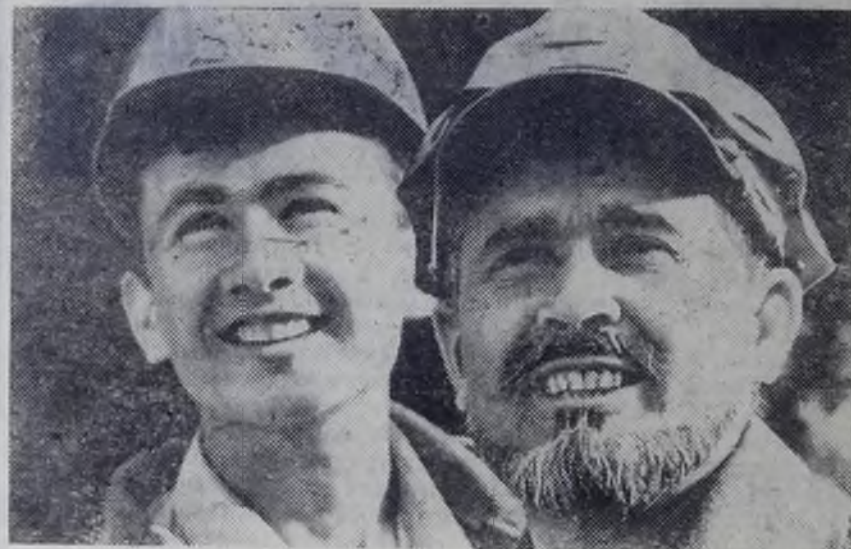
Таджикская ССР. На Нурекской ГЭС приступили к новому этапу работ. На бетонное основание плотины уложены первые кубометры суглинка. Суглинок станет ядром плотины, высота которой достигнет трехсот метров.
