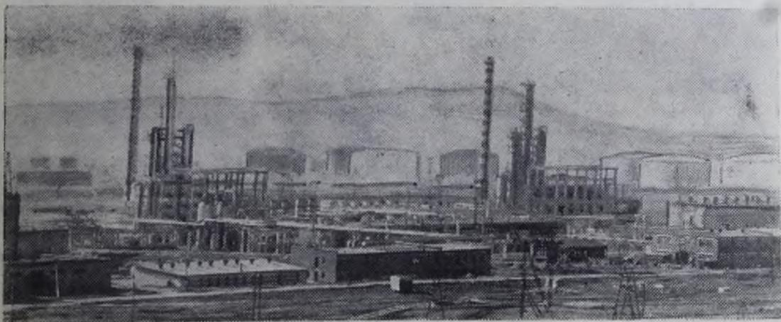
**Чечено-Ингушская АССР.** В предгорьях Терского хребта введен в эксплуатацию Вознесенский газобензиновый завод (на снимке). Новое предприятие перерабатывает попутный газ, получаемый при эксплуатации нефтяных скважин.
