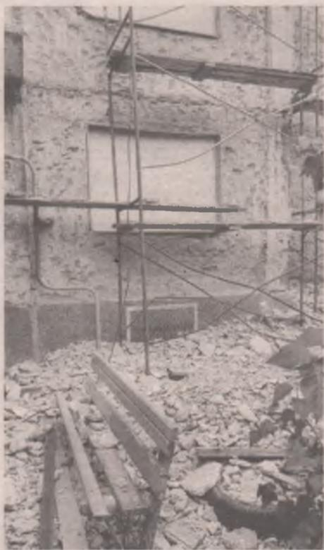
«С 26 июля мы выполняем работы по усилению наружного слоя стен, – говорит руководитель подрядной организации «Горстройпроект» Алексей Плотников. – Согласно проекту мы снимаем часть облицовки – то, что отходит практически само. Армируем, заливаем легким бетоном и наносим теплоизоляционное покрытие. Срок завершения работ – конец октября».
