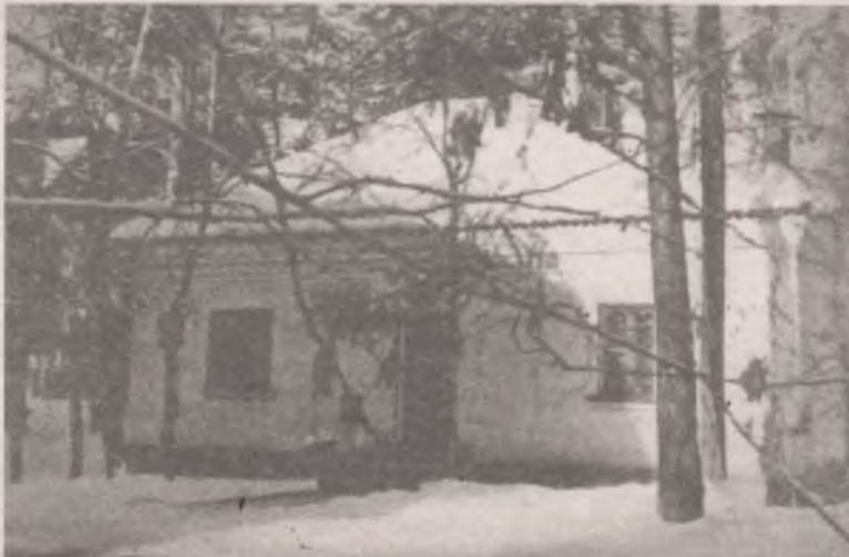
Первое здание «скорой помощи» в 60 квартале
