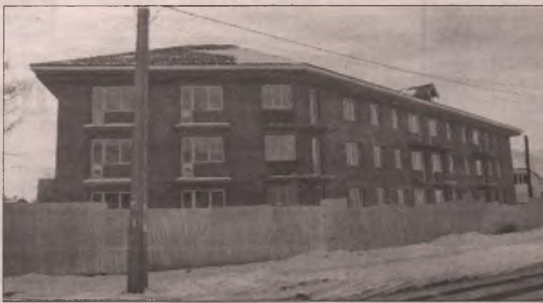
В этом доме в 6а микрорайоне часть квартир будет отдана под проект «Арендное жильё».
