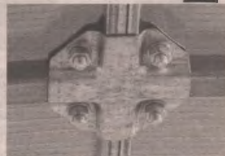
Сборка на хомутах прочнее и жестче сварки
