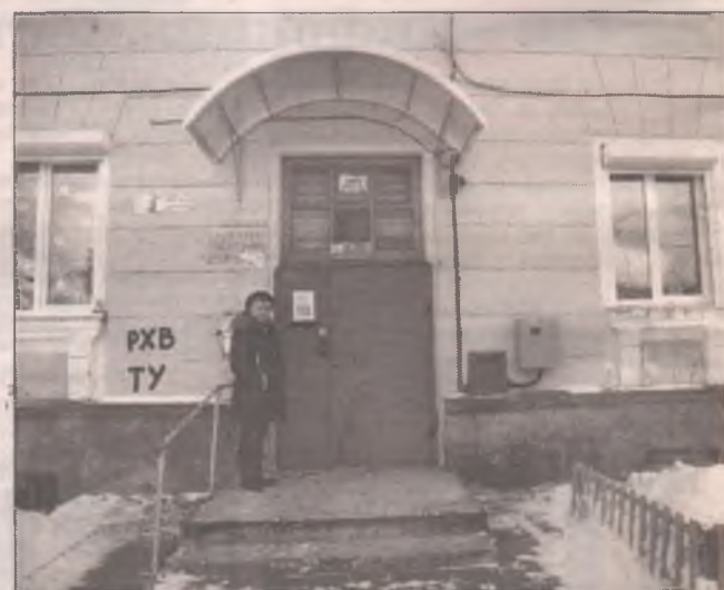
Устав просить ООО «ЖЭУ-6», жильцы этого дома собрали деньги и сами установили над подъездами козырьки.
