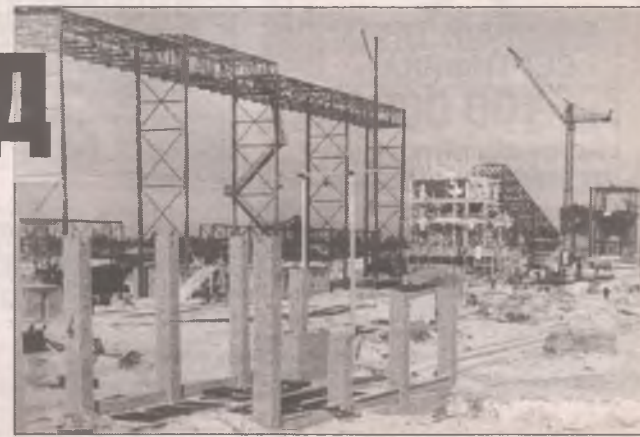
Строительство завода гидрирования. 1951 г.
