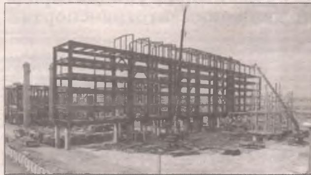
Строительство установки гидроочистки дизельного топлива. 2013 г.
