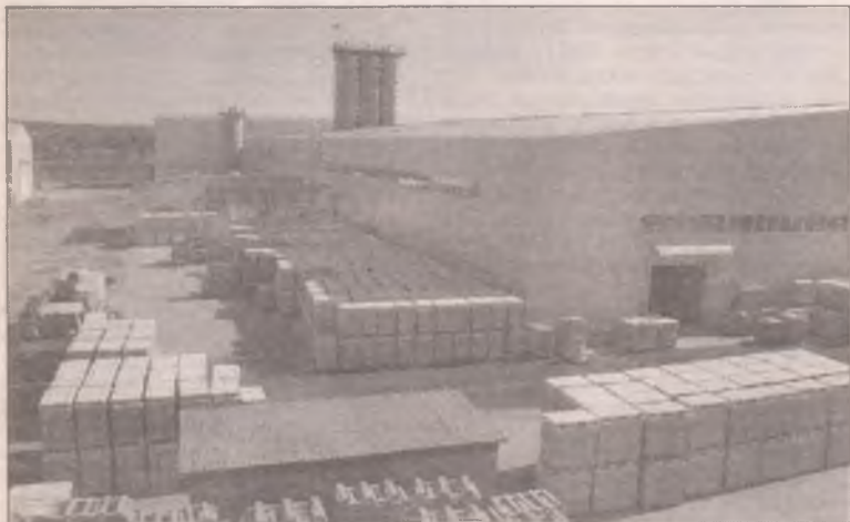
Завод автоклавного газобетона «Стройкомплекс» построил с нуля: буквально в чистом поле. Стоимость завода составила миллиард рублей. Оборудование из Германии вез караван из 40 фур, автоклавы прибыли на железнодорожных платформах для транспортировки космических ракет. Сейчас в Ангарск приезжают перенимать опыт японцы и немцы – в том числе и те, у которых было изначально закуплено оборудование.
