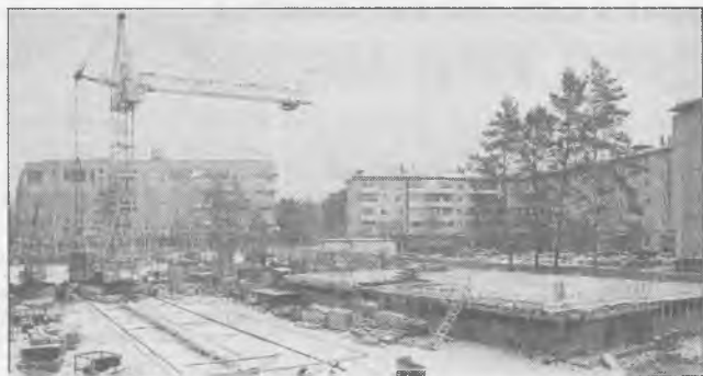
Полным ходом идет строительство многоэтажек нового жилого комплекса в 22 микрорайоне. На сегодняшний день здесь самый большой выбор 1-, 2- и 3-комнатных квартир. Сдача первых блок-секций этого объекта запланирована на конец 2012 года.
