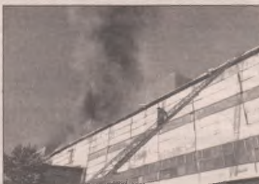
По прибытии подразделений происходило горение кровли цеха №2 на площади 700 кв.м. Была угроза возгорания взрывоопасного порошка и его составляющих.
