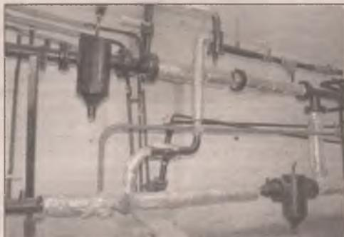
ющий этап – подготовка тепловых узлов, переборка арматуры, проверка элеваторных узлов и шайб, замена задвижек.
