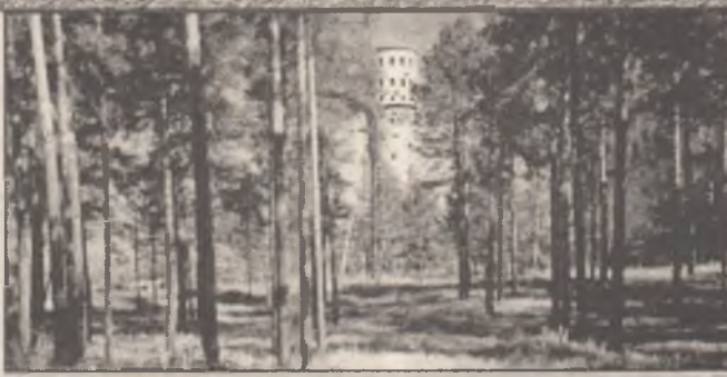
Водонапорная башня. Мимо нее мы ходили в политотдел, расположенный по улице Пушкина напротив рынка.
