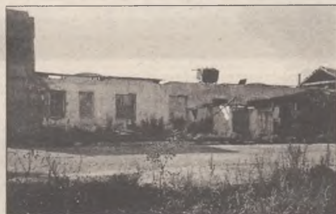
Штрафной изолятор 11-го лагеря. Окна были величинной в одну треть от теперешних, сверху и с решетками. Крыша, которая теперь развалилась, была высокая, из щепы. В 50-х годах в этом бараке располагалась гауптвахта. (Фото автора, 02.10.2000 г.)
