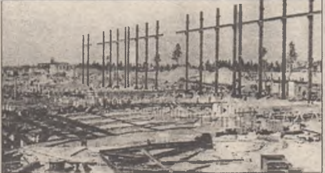
Строительство первой ТЭЦ. 1950 г.
